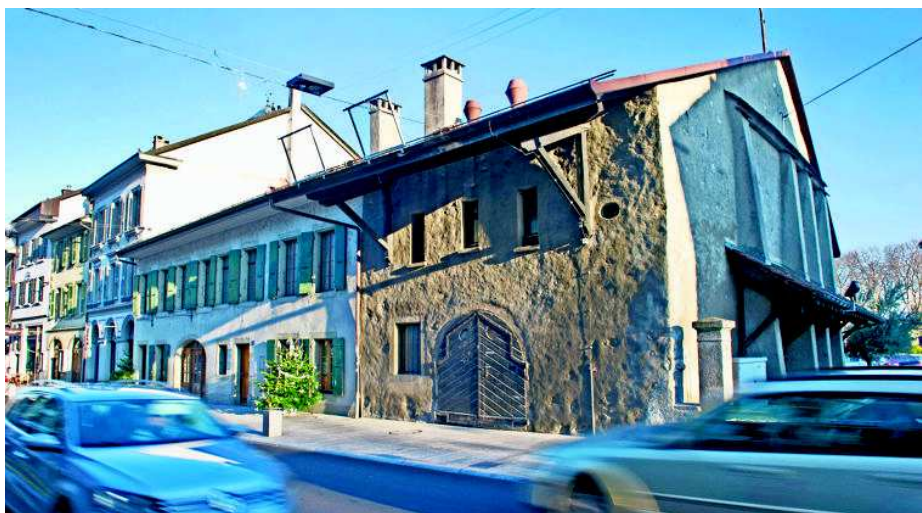
Le bâtiment devra subir d'importantes interventions sur l'isolation et les installations techniques. VANESSA CARDOSO
