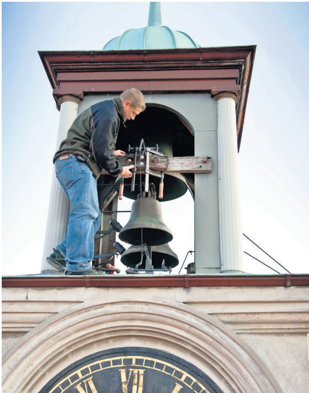
En attendant une grande rénovation de la tour de l'Horloge, Christophe Rojard, responsable des concierges communaux, a participé aux travaux temporaires. GÉRALD BOSSHARD
