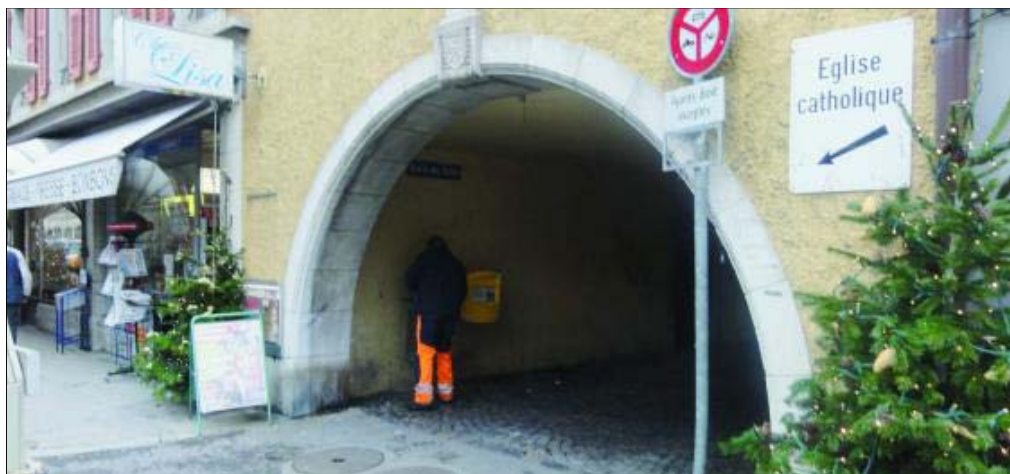
Un imposant canal sera construit sous la ruelle des Halles.
