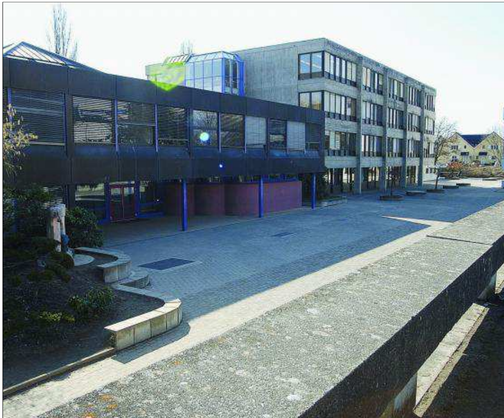
Le complexe scolaire du Martinet va subir un sérieux lifting. Les travaux débutent en avril.
