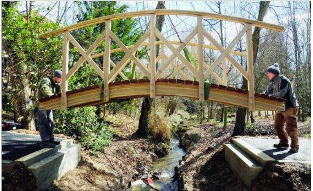
La passerelle enjambant le Langollioux est posée avec précaution.
