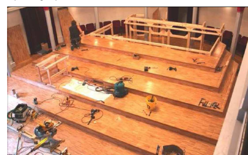
Durant les travaux de pose des gradins.
