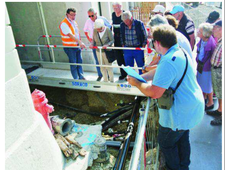
Le 11 septembre, le public a pu découvrir le chantier et rencontrer ses acteurs principaux. VINCENT LEHMANN
