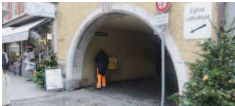
Les sous-sols de la ruelle des Halles vont subir un coup de jeune. LMO
