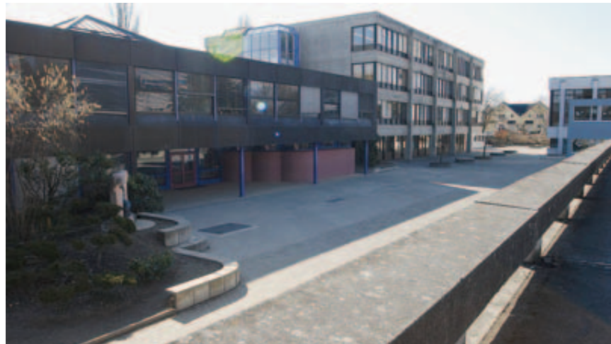
Le plus ancien bâtiment du Martinet a été construit en 1970, les deux autres, en 1974 et 1987. Aujourd'hui, il est urgent de réhabiliter le collège pour le confort de ses usagers. ARCHIVES T. HUF
