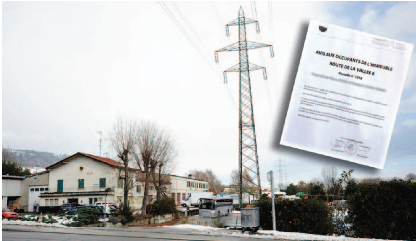
Un logement, une école de musique et différents artisans locaux occupent le bâtiment situé entre la bretelle d'autoroute et l'A1. AUDREY PIGUET ET SAMUEL FROMHOLD
