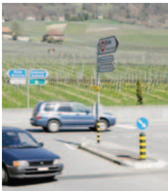
Les travaux de création du giratoire débutent lundi. SAMUEL FROMHOLD
