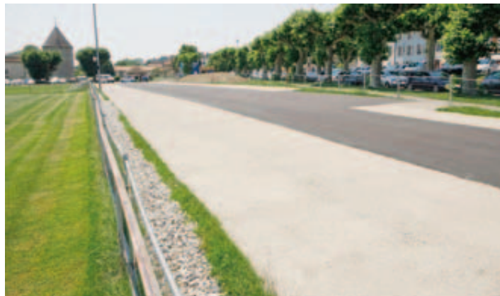
Le parking provisoire pourra accueillir 93 véhicules. Cette nouvelle zone de stationnement sera limitée à deux heures. SAMUEL FROMHOLD
