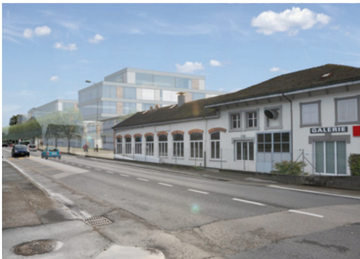
La hauteur des immeubles locatifs, qui seront érigés sur l'ex-parcelle Roch-Tesa, a cristallisé les oppositions. DR/GEA VALLOTTON ET CHANARD SA
