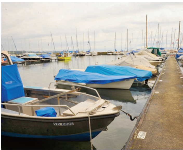
La rénovation du port et son extension portera sa capacité à 442 places et 20 places visiteurs. L'objectif: une réalisation pour 2016. ARCHIVES LA CÔTE
