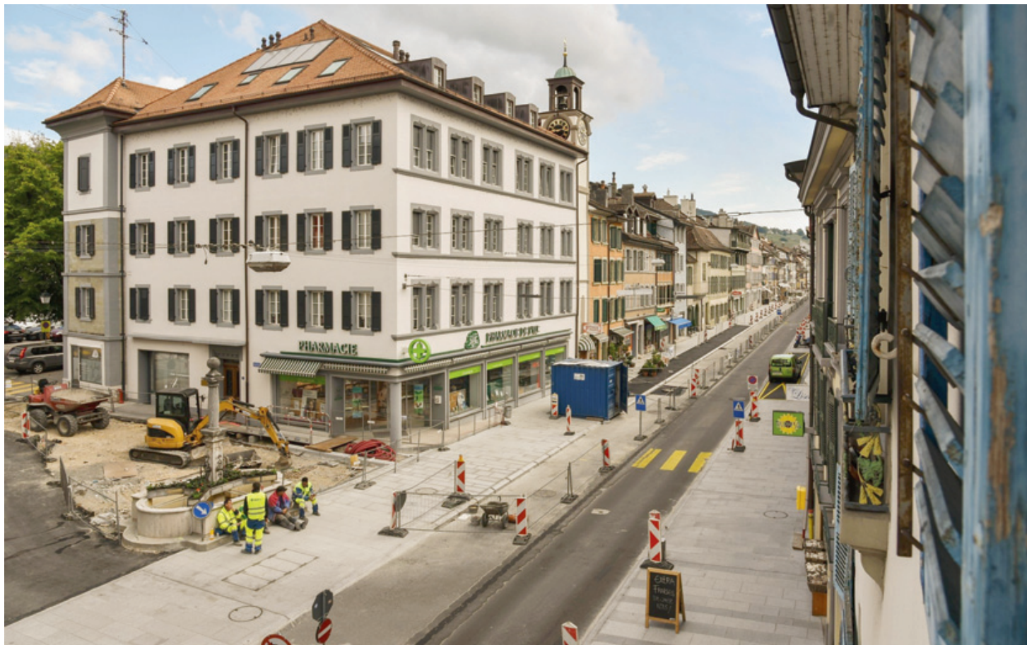
Au carrefour central, les riverains ont connu les travaux de réfection des infrastructures à la ruelle des Halles avant le début du chantier massif de la Grand-Rue. Aujourd'hui, alors que les aménagements sont bientôt terminés, l'heure est au soulagement. PHOTOS CÉDRIC SANDOZ ET SANDRINE BOLLMANN
