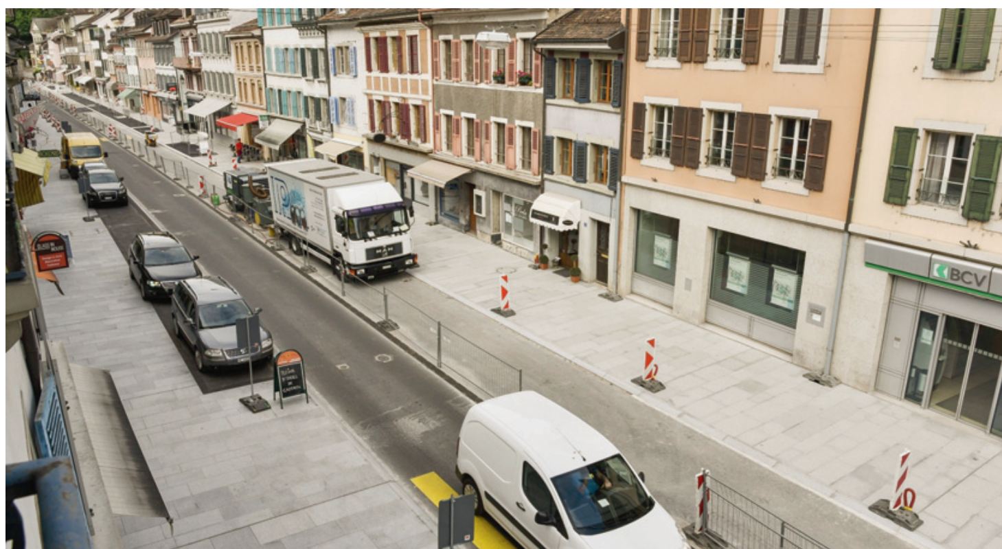
Les dalles de granit recouvrent déjà tous les trottoirs situés dans la partie ouest de la Grand-Rue. ARCHIVES CÉDRIC SANDOZ
