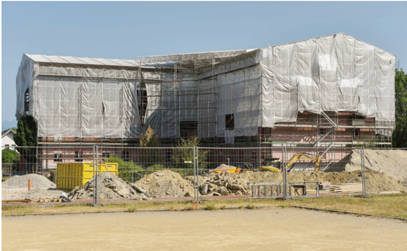
L'immeuble est comme enveloppé dans une bâche. Un habit qui protège le bâtiment et permet de travailler en cas de pluie. CÉDRIC SANDOZ
