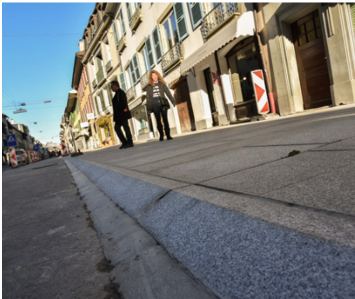
Les travaux dans la Grand-Rue se terminent fin août. Les autorités se félicitent d'avoir respecté les délais. ARCHIVES CÉDRIC SANDOZ
