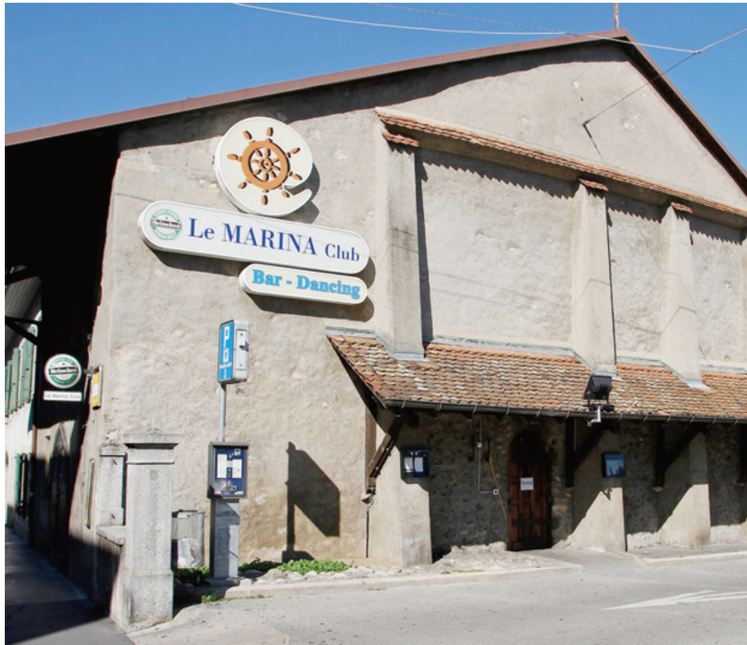
La volumétrie du bâtiment est classée en note 3 au recensement architectural du canton. ARCHIVES LA CÔTE
