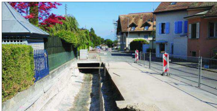
Les travaux à l'avenue Châtelain avancent bon train. Ici, on aperçoit le canal du Torrent à ciel ouvert.
