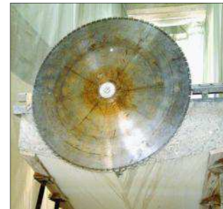
Cette scie aux dents de diamants a servi à découper les étages pour faire place aux nouveaux escaliers.
