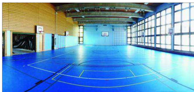
Une vue des salles de gym, après la pose de la résine au sol.
