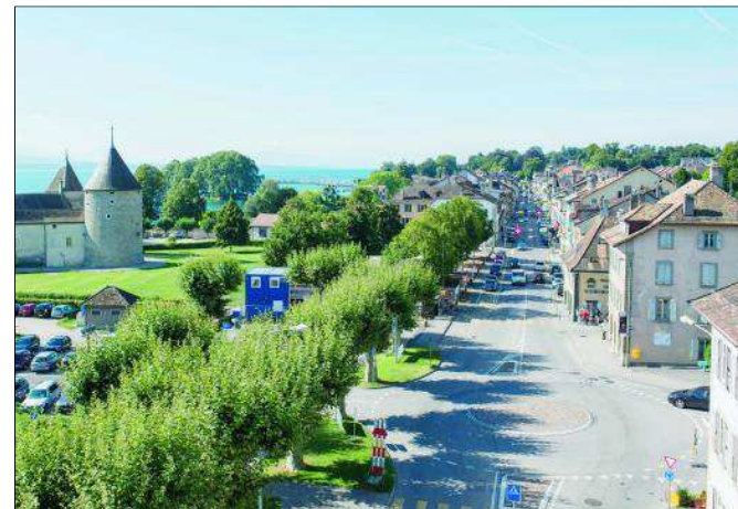
En perspective, la Grand-Rue à l'aube de sa métamorphose avec, au premier plan, le giratoire permettant la déviation durant les travaux.
