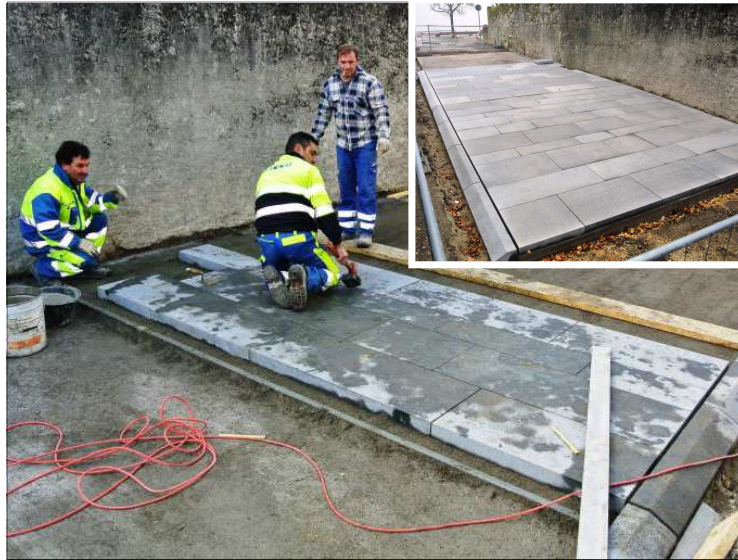
Les pierres de granit, récemment posées, proviennent d'Espagne (gris clair), du Portugal (gris clair) et de Chine (gris anthracite). L'un de ces matériaux revêtira la nouvelle Grand-Rue.
