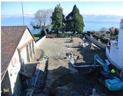
Le parking de la Tête Noire, actuellement en travaux.
